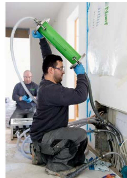
Im Rahmen einer Komplettanierung mit dem HAT-System werden die Heizkreise mit einer Epoxidharzlösung von innen neu beschichtet.
