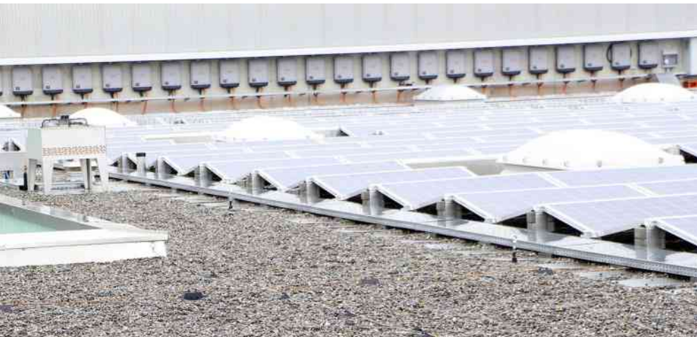
Auf dem Dach erstreckt sich auf einer Fläche von 7200 m 2 eine Photovoltaikanlage (Leistung: 1,1 MW p ). Im Hintergrund hinter einem Blechvordach sind die Wechselrichter aufgereiht.
